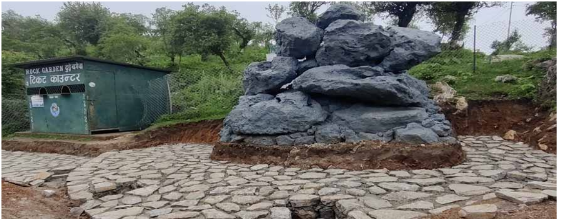
रोल्पा न.पा. १, सातदोबाटोमा रक गार्डेनमा निर्माण कार्य हुँदै ( मिति २०७८/०३/२१)
